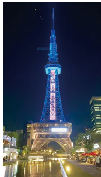
中部電力MIRAI TOWERタワービジョン「煌」への広告
